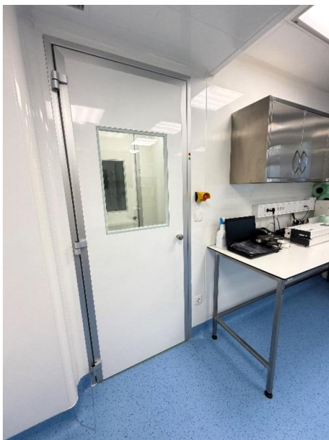
Slika 5 in 6: Osebni prehod PAL (Personal Airlock) in pasivna predajna komora z interlock sistemom, 2024; vir: Mollier d.o.o. Celje.
